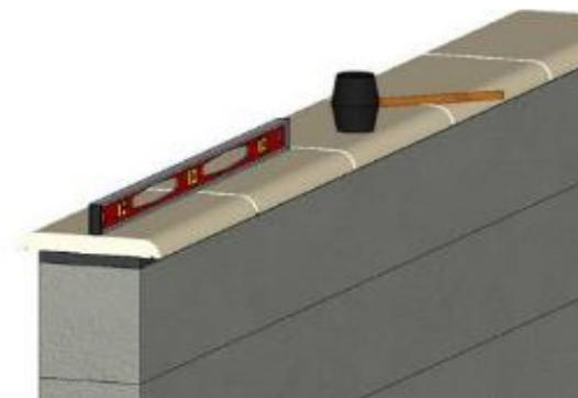
► 4 - Bien vérifier le niveau et l'alignement des dessus de mur à l'aide d'une règle et d'un niveau à bulle, puis taper doucement avec un maillet (blanc de préférence).
