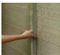
►12 - La pose d'un minéralisant teinté est conseillé, obligatoire pour les coloris ton bois étuvé, ton bois et ton gris anthracite afin d'imperméabiliser et d'homogénéiser la
