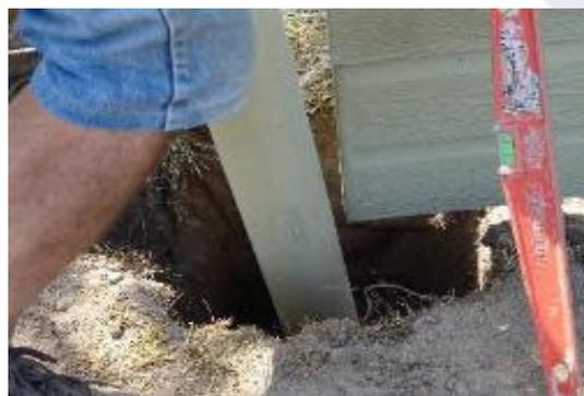
► 6 - Sceller le deuxième poteau en insérant les plaques. Vérifier l'alignement au cordeau, les aplombs et la hauteur hors sol devant être de niveau par rapport au premier poteau (idem au premier poteau sur sol de niveau).
