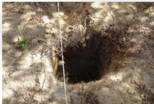
► 4 - Sceller le premier poteau avec du béton dosé à 250kg/m<sup>3</sup> de ciment. Vérifier les aplombs ainsi que la hauteur hors sol voulue (exemple : 2.00m hors sol).
